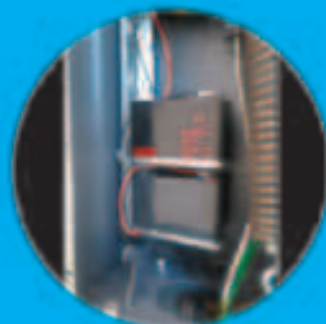
Pomocniczy system zasilania na akumulatory
